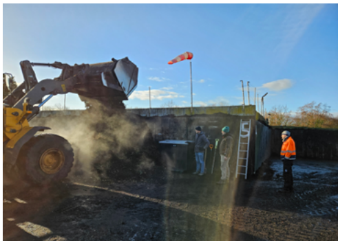
Einbau des Testsystems für die Porengasmessung der Grüngutkompostierung
